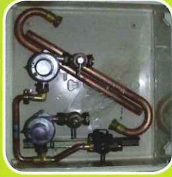
Coffret S300 double comptage moyenne pression
