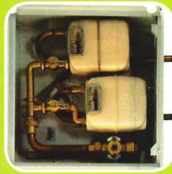
Coffret S300 double comptage basse pression
